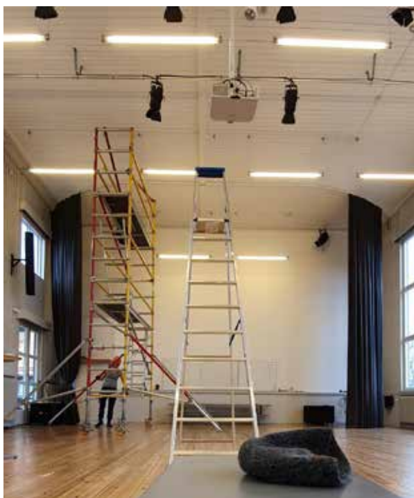
Jenny Elvelin tar ned den gamla utrustningen från taket.
